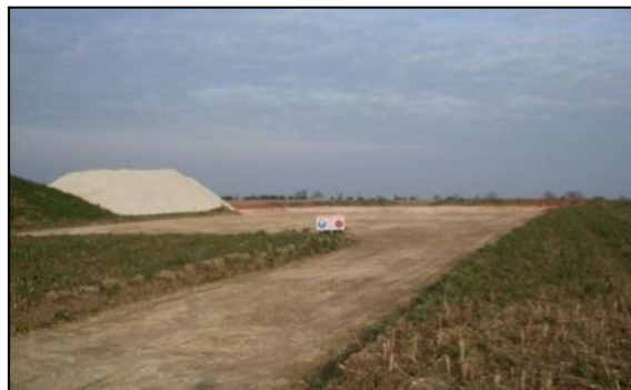
Figure 11 : Exemple d'une aire de montage (source : BURGEAP)
