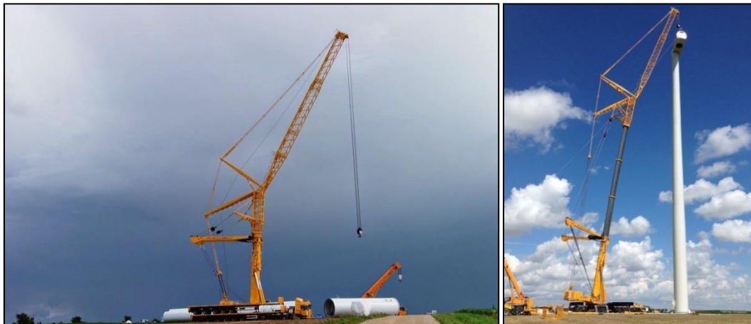
Figure 29 : Exemple de montage des éoliennes (source : BURGEAP)
