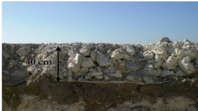
Figure 25 : Type de remblais utilisé pour le renforcement des chemins
