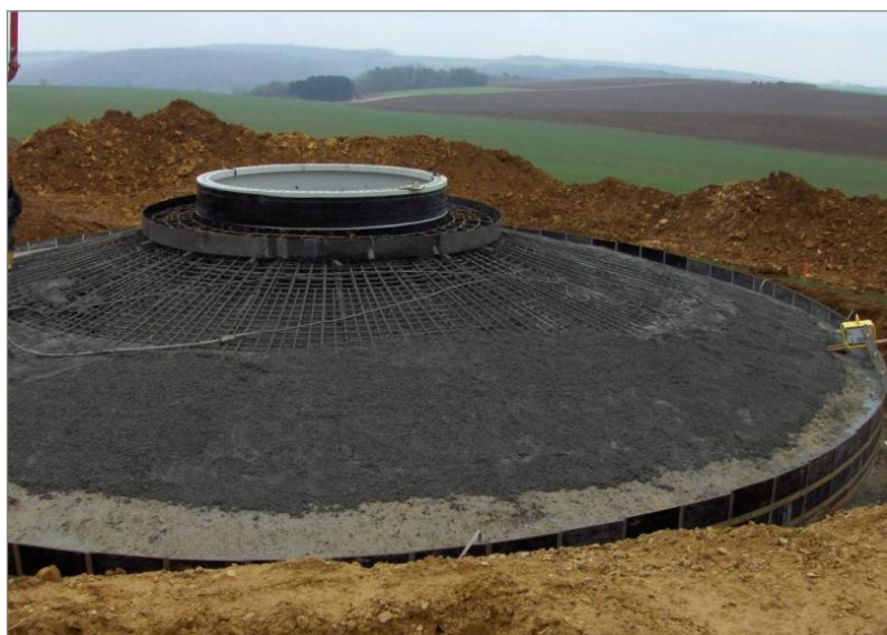
Figure 13 : Exemple de ferrailage en radier pour une éolienne (chantier en cours)
