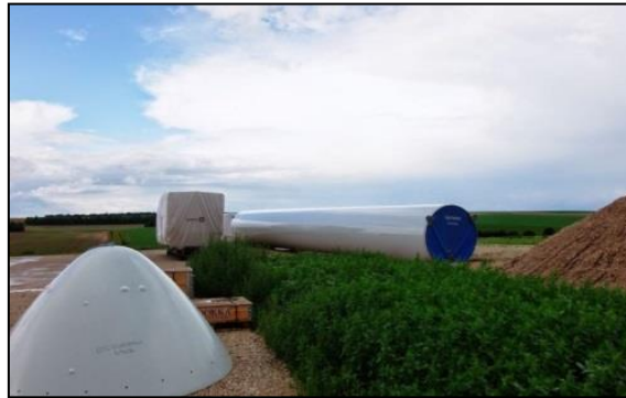
Figure 10 : Exemple d'une zone de stockage en phase travaux (source : BURGEAP)
